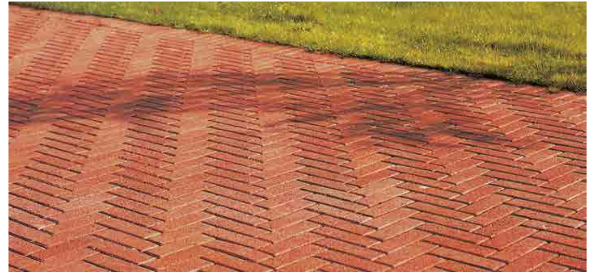
Dettaglio di pavimentazione di "Listellino" colorazione Rosso Mattone posato a spina di pesce stile cotto con pettine finale dello stesso colore posato in sabbia e cemento a livello del prato erboso.
